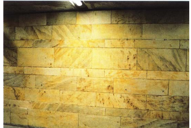
Abb. 10...ein Foto aus einem Zwischenstadium. Heute sorgt ein semipermanentes, atmungsaktives Opferschichtsystem auf Siloxan/Wachs-Basis für Entfernungen mit Heißwasser und Hochdruck-Absaugkrake.
