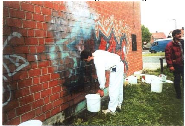
Abb. 6: Graffiti-Entfernung auf Opferschicht-System - Vorbehandlung mit wässrigen Reinigungsmitteln ...
