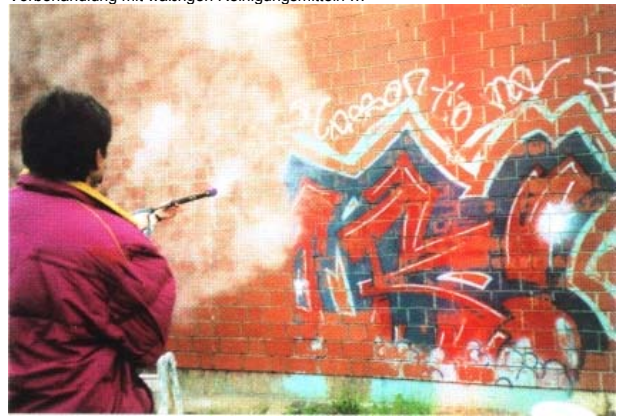
Abb. 7: ... Heißwasserdampf-Abstrahlung...
