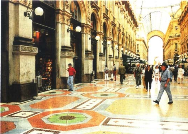
Abb. 4: Mailand, Passage am Dom: Nicht wasserdampfdurchlässiger Permanentenschutz wirkte nicht auf Naturstein...
