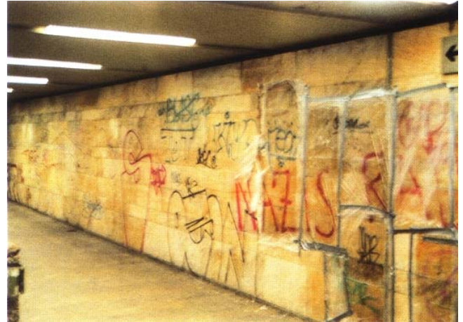
Abb. 9: Tatort U-Bahn Nürnberg: In dieser Station hatte man die Spray-Schmierereien nicht sofort entfernt, wodurch ständig neue hinzukamen und vor allem die Beseitigung nach über sechs Jahren Haftung besonders schwer wurde...
