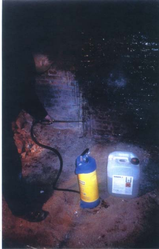
Abb. 1: Schwammsanierung mit Borpräparat nach dänischem Vorbild
