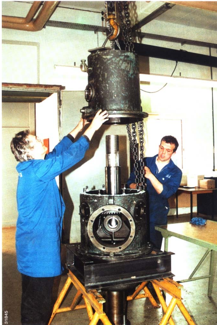
Bild 9 Demontage des Winkelgetriebes einer Wasserturbine mit Hilfe einer Abziehvorrichtung (vgl. Bild 10)
