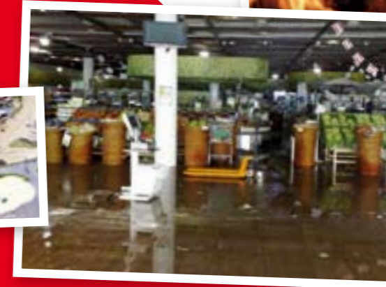
Massiver Wassereintritt nach Löscharbeiten im Merkur-Markt in Bad Vöslau.
